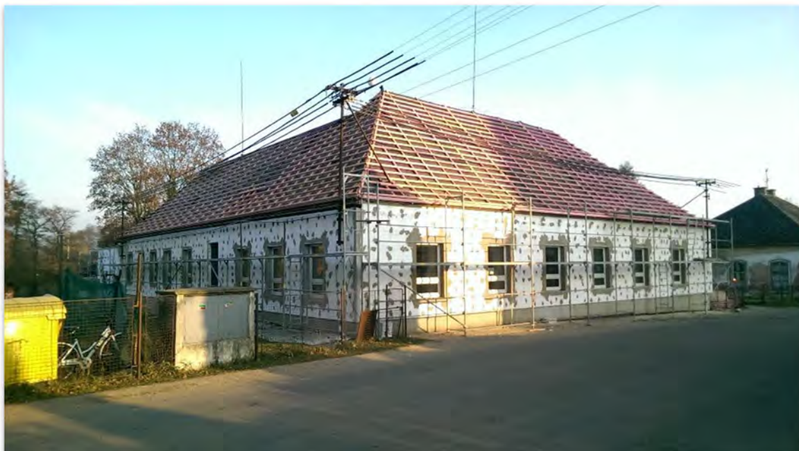
Z průběhu oprav vnějšího pláště
