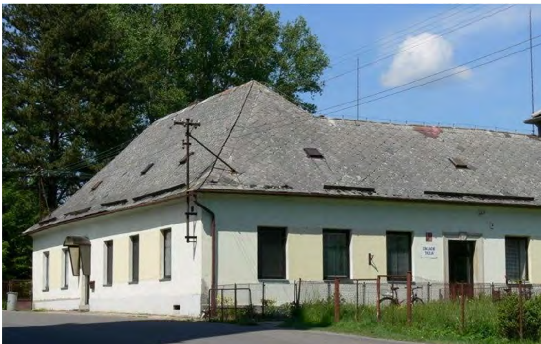
Budova ZŠ a MŠ před opravou
