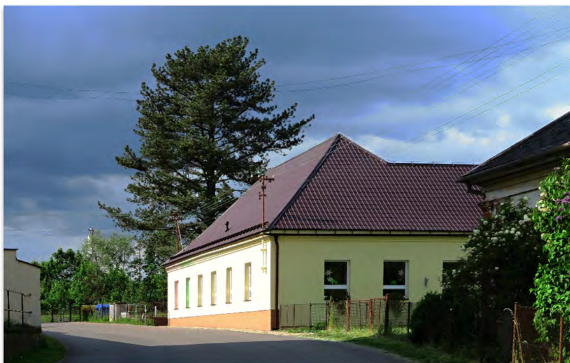
Opravená budova ZŠ a MŠ Luková
