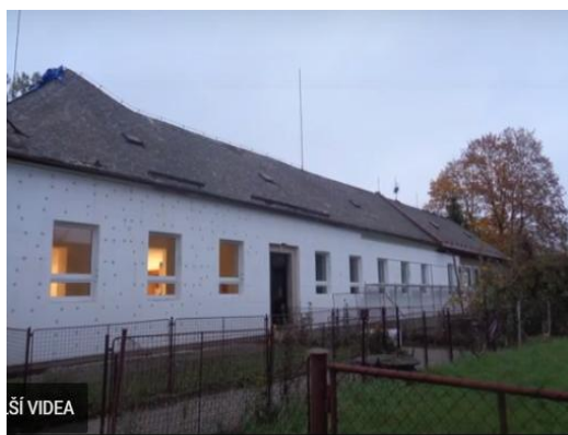
Vnější plášť celé budovy zateplen, z druhé strany je vchod do mateřské školky
