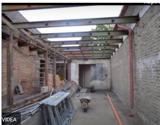
Příprava na zastřešení dvorečka
