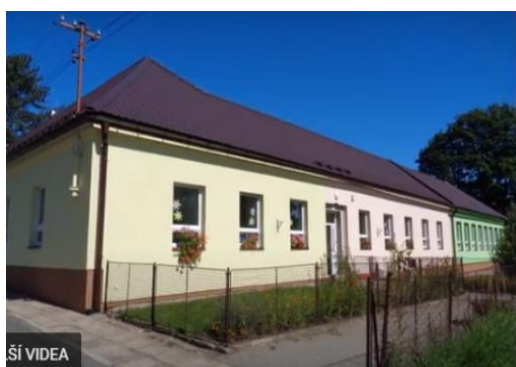
Zateplení vnějšího pláště provedeno
