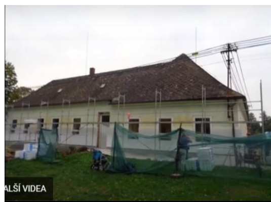
Okna vyměněna, pokrývání vnějších zdí zateplovacími deskami
