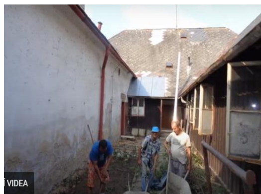
Odstranění dřevěné stěny u dvorečka
