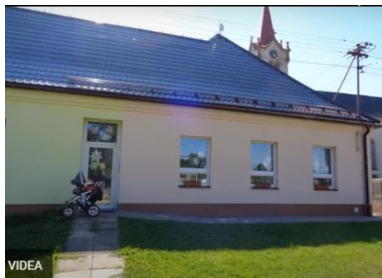
Nová fasáda, hotová je i nová střecha
