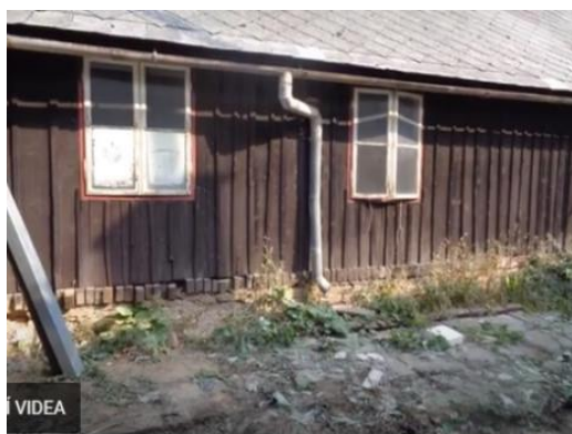
Dosavadní jednoduchá vnější stěna s jednoduchými okny u dvorečka
